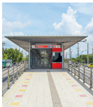
Estaciones comienzan a ser vandalizadas.
