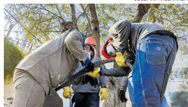
Operarios de la empresa reparan la red.
